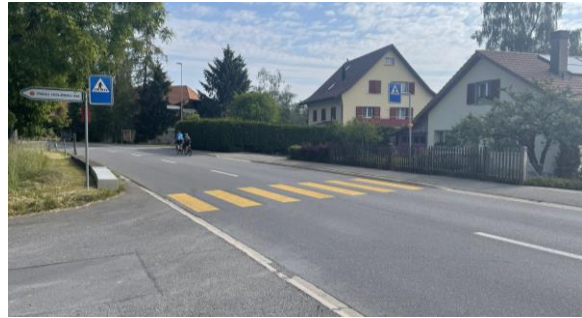
Abb. 9: Südlicher Fussgängerstreifen bestehend, Blickrichtung Nordost
