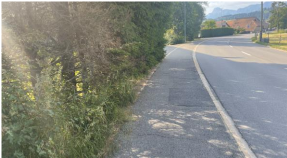
Abb. 4: Trottoir östliche der Kantonsstrasse, Blickrichtung Süd
