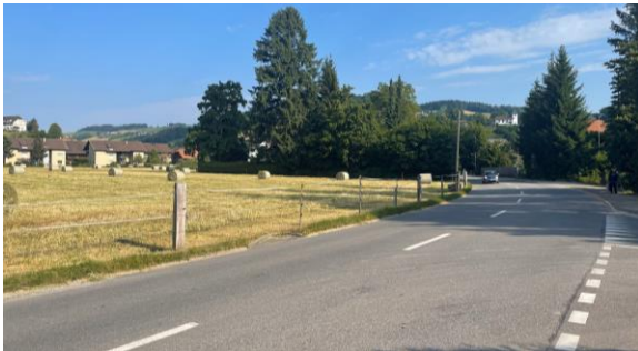
Abb. 1: Gurnigelstrasse vor Grst. 781, Blickrichtung Nord
