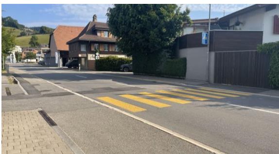
Abb. 6: Nördlicher Fussgängerstreifen bestehend, Blickrichtung Nordost
