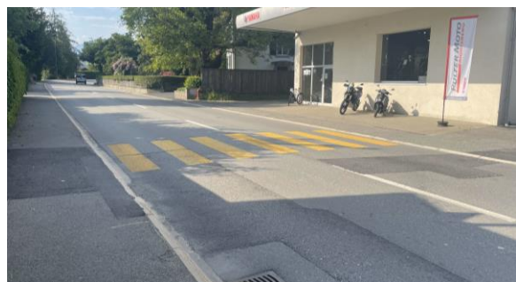
Abb. 7: Nördlicher Fussgängerstreifen bestehend, Blickrichtung Südwest
