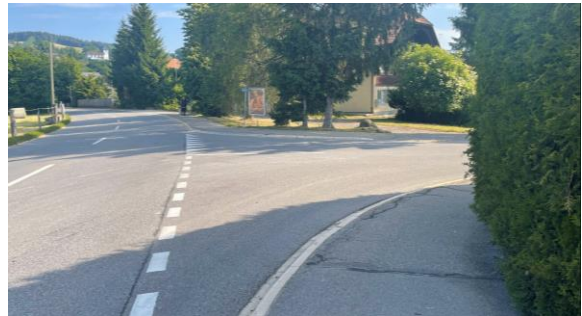
Abb. 2: Einmündung Halbbachweg in Gurnigelstrasse
